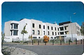
EHPAD LES TERRASSES 3 Rue Blaise Pascal 42 160 ANDREZIEUX-BOUTHEON
