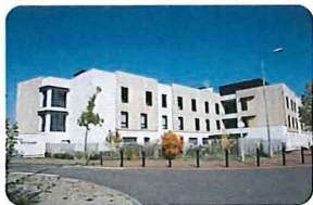
EHPAD LES TERRASSES 3 Rue Blaise Pascal 42 160 ANDREZIEUX-BOUTHEON
